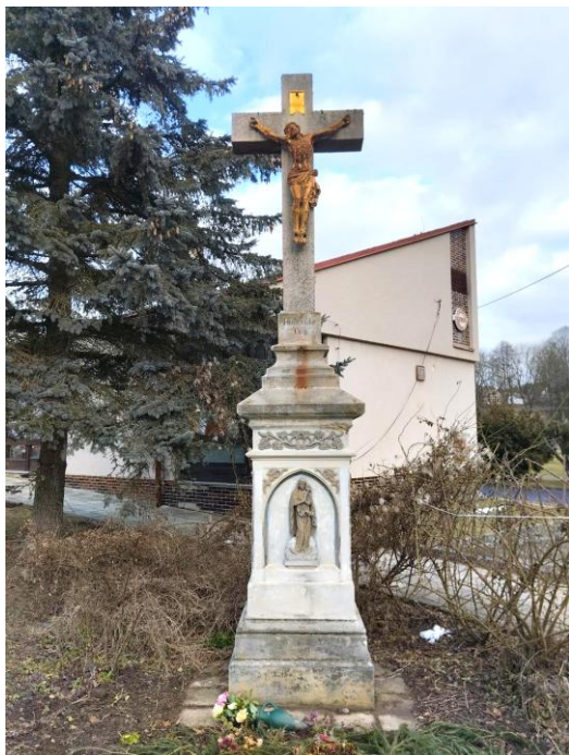
Před restaurováním – konec roku 2024
