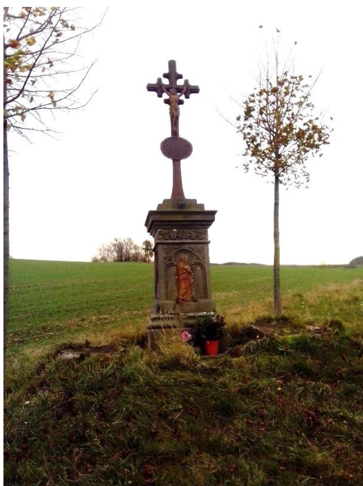
Před restaurováním – konec roku 2024
